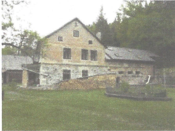
Heutige Ansicht Girschen, Hammerwerk (ehemaliger Waffenhammer)
